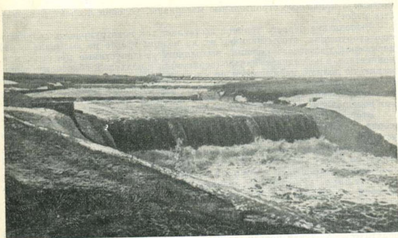
Рис. 6—4. Пропуск весеннего паводка через многоступенчатый перепад.
