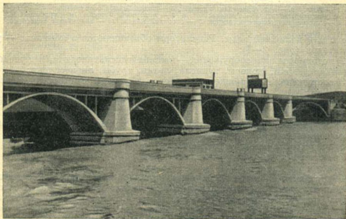
Рис. 2—3. Вид с верхнего бьефа на плотину с сегментными затворами: справа — водозаборный пролет; речные пролеты плотины открыты.
