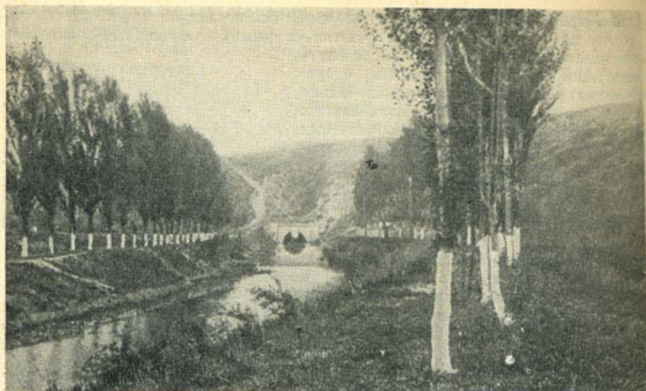
Рис. 5—31. Вход оросительного канала в туннель.
