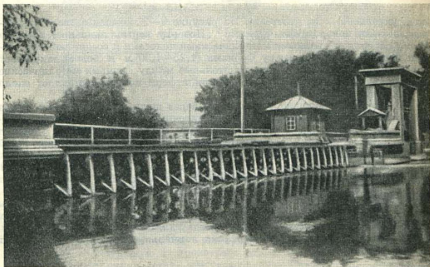
Рис. 9—4. Верхний бьеф плотины с поворотными фермами.
